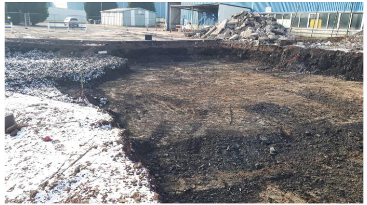
Fond de fouille M7 et M8 après reprise
