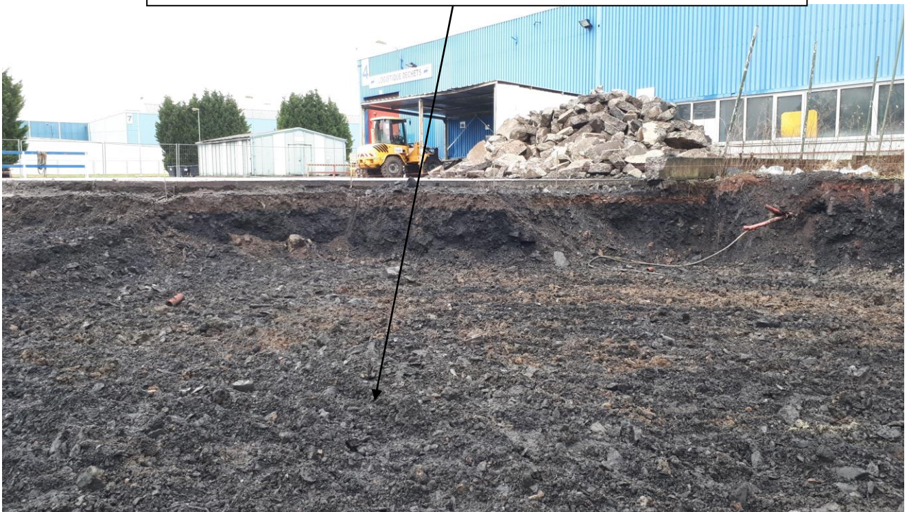
Fonde de fouille M7 et M8 à finir de purger jusqu'au terrain naturel (limon beige)
