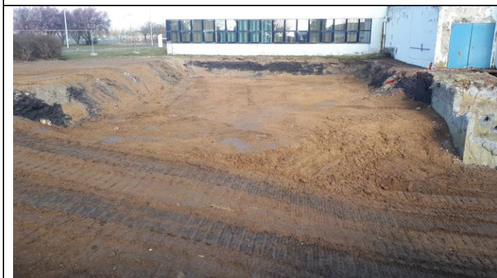
Remblaiement zone cuve 1 à 4
