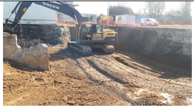
Remblaiement zone FF4 / FF5
