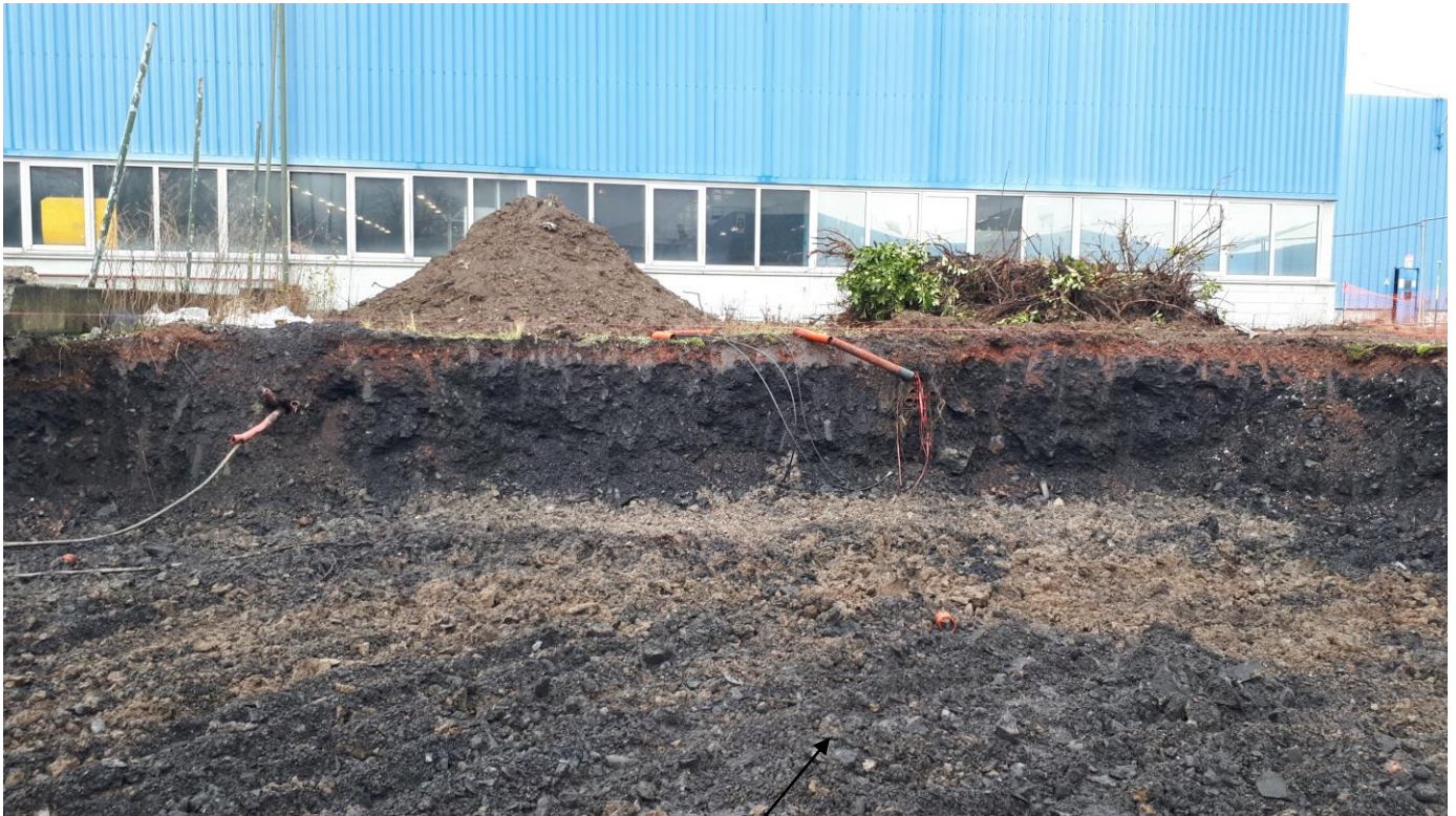
Fonde de fouille M7 et M8 à finir de purger jusqu'au terrain naturel (limon beige)
