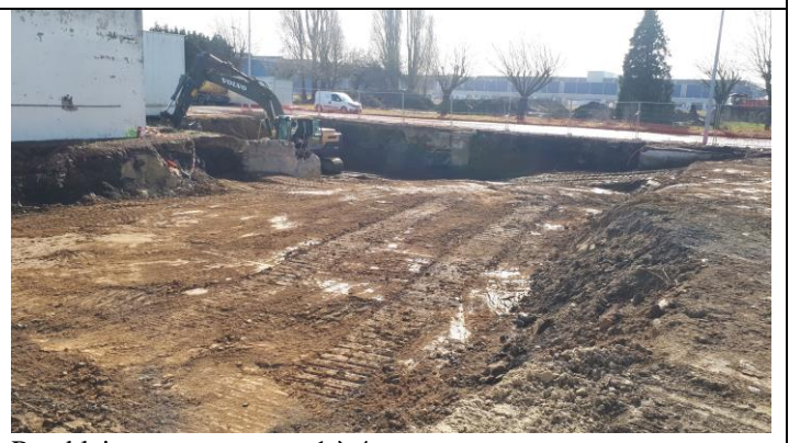
Remblaiement zone cuve 1 à 4
